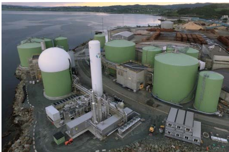
Biokraft AS anlegg for produksjon av biogass i Skogn
